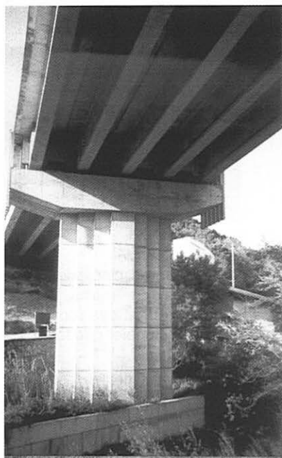
Figure IV.6 : Vue du pont « C ».
