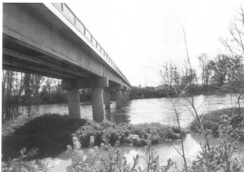
Figure IV.1 : Vue générale du pont « A ».
