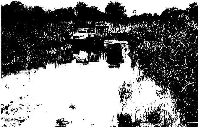
61. point bas pour la route: point bas pour le marigot - la route est coupée pour plusieurs jours - route Tchibanga-Voungou (Gabon)
