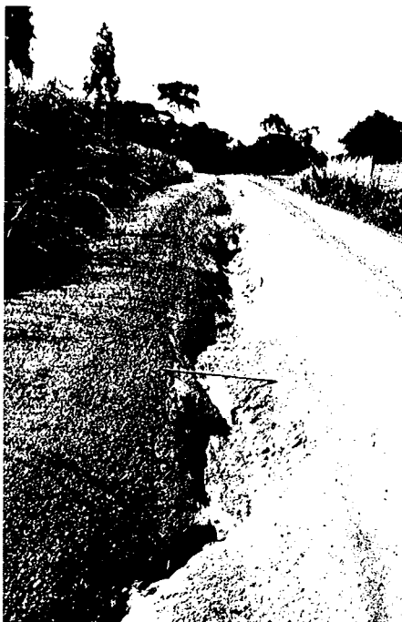
65. où elle peut creuser des ravines de plus de 20cm de profondeur, jusqu'au sol support - comment les réparer ?
