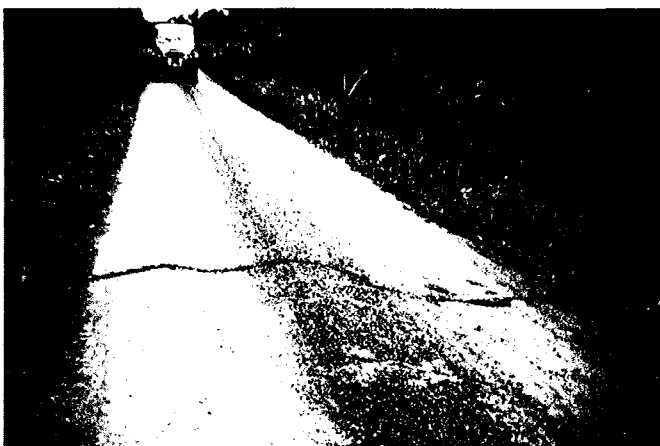
75. accotements envahissants (et colonne de magnans qui traverse la chaussée)
