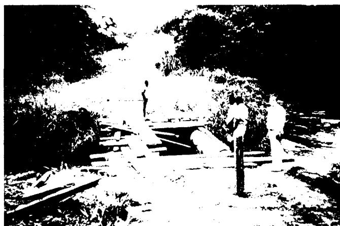
110. un accident sur un ouvrage et la circulation est interrompu pour longtemps parfois...
