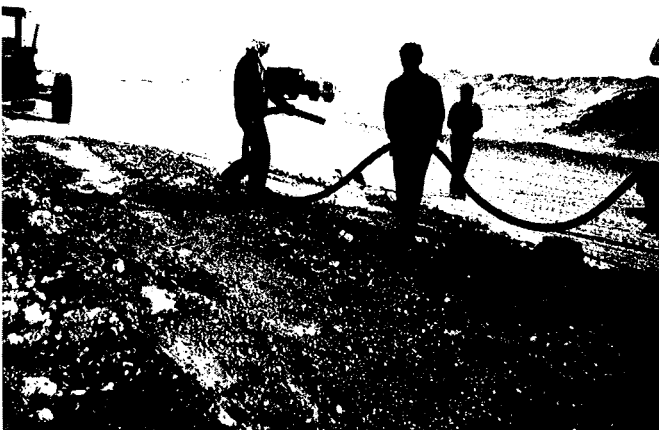
85. entretien lourd : rechargement d'une route dans les émirats arabes - opération d'humidification des matériaux
