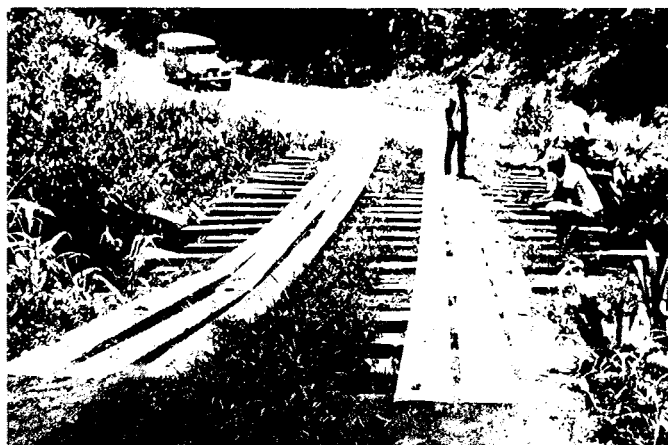
106. pont de troncs d'arbres avec platelage en planches et chemin de roulement
