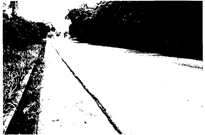
133. protection contre les pluies tropicales : la couche de base bitumineuse est prolongée jusqu'au fossé bétonné - Vénézuéla
