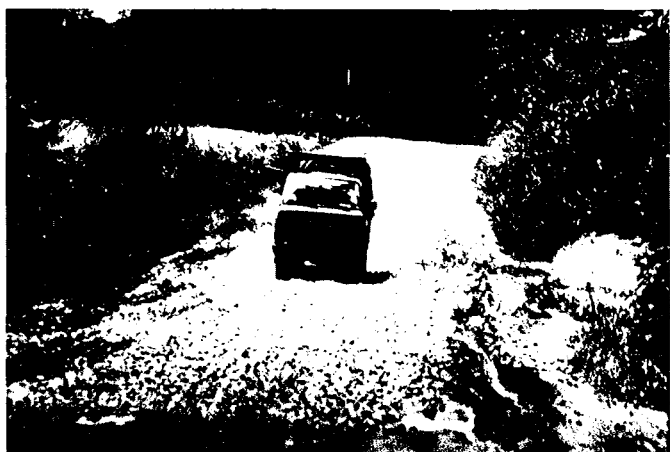
89. le travail terminé - la route attendra la fin de la saison des pluies pour une reprise locale
