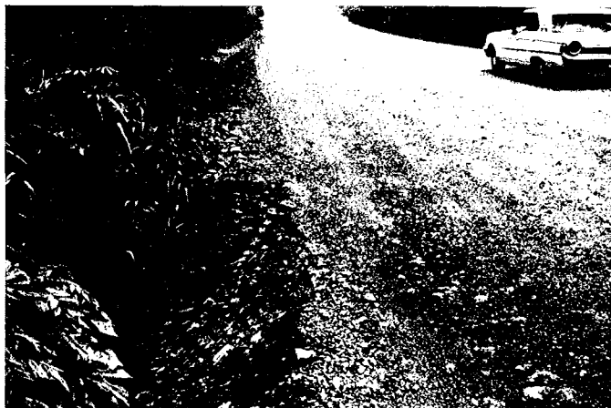
37. texture pierreuse, grave concassée sans cohésion Vénézuéla
