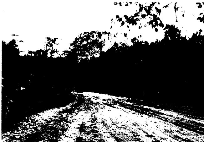
29. texture sableuse; mauvaise tenue de la surface et forte résistance au roulement - Côte d'Ivoire Plateau continental terminal
