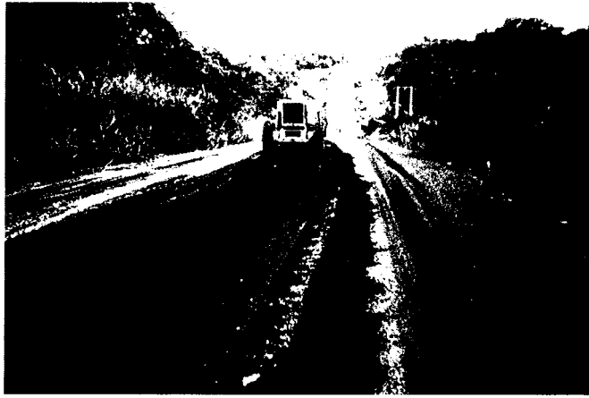
81. profilage léger avec une niveleuse sans compactage
