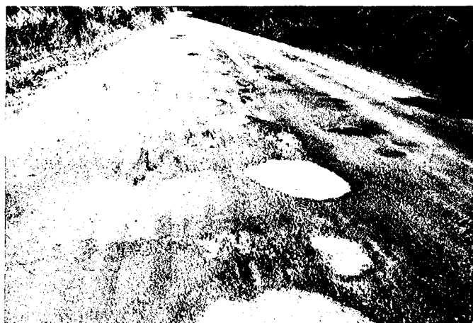
52. chapelet de nids de poule qui ne pourra pas être repris de manière durable par un simple nivellement
