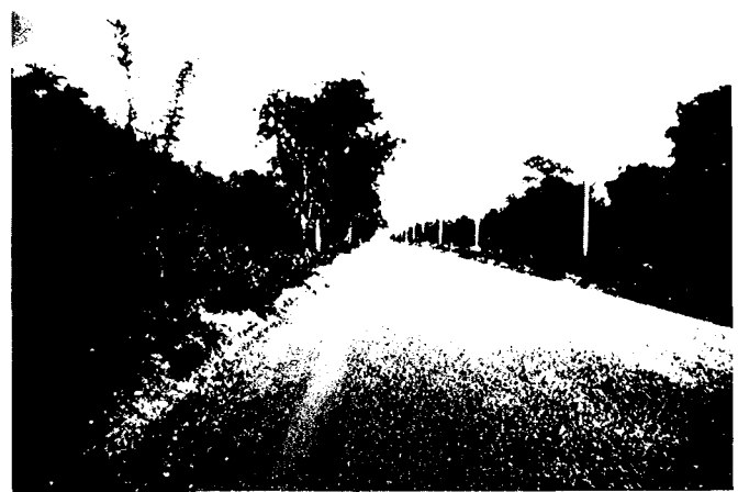
135. une belle chaussée en enduit superficiel au Laos
