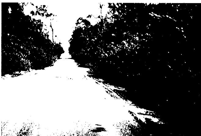
150. reprofilage des rives par du graveleux pour éliminer la dentelle - route Sikasso-Zégoua (Mali)
