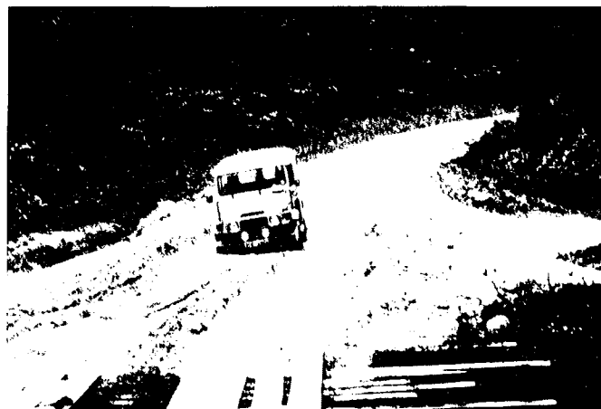
56. bournier rendant périlleux ou acrobatique l'accès du pont en bois - route Tchibanga-Mayumba (Gabon)
