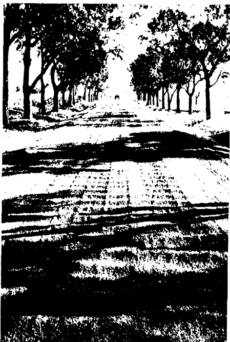
47. tôle ondulée en climat sahélien
