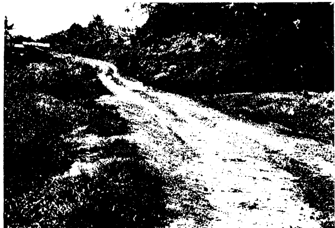
64. fossés absents ou inefficients : l'eau circule sur la chaussée
