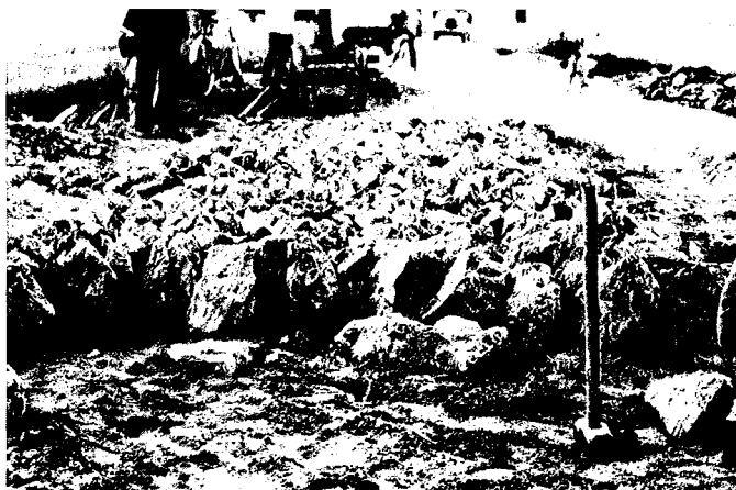
39. pose du hérisson sur lit de sable
