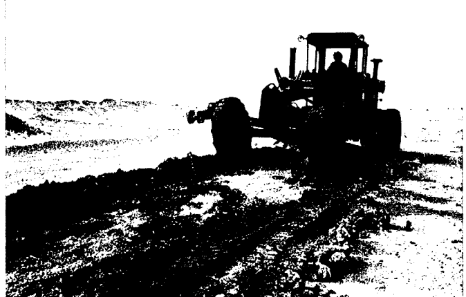
86. entretien lourd : réglage du matériau humidifié avant compactage
