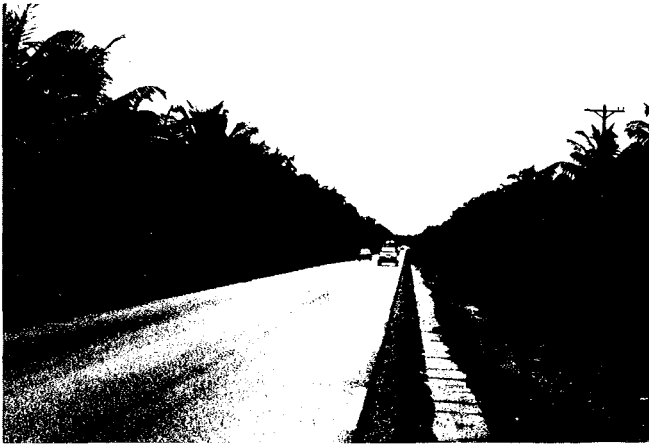
132. imperméabilisation des accotements - La côtière Abidjan-Grand Bassam Côte d'Ivoire
