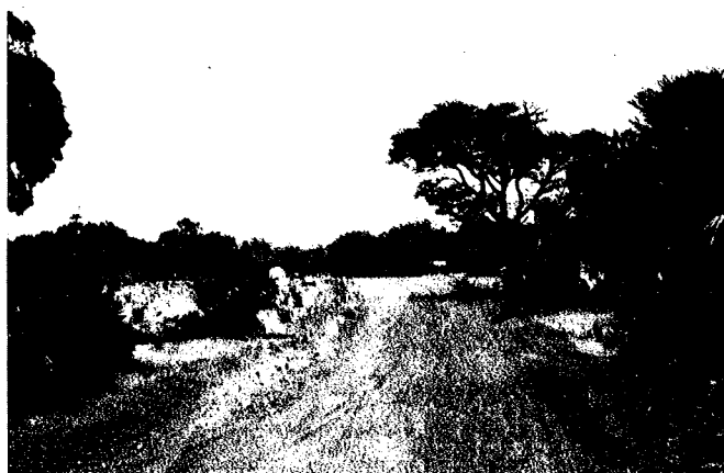
12. route Nationale n° 1 au Niger - DIFFA (région du lac Tchad) chaussée en sable (50 à 100u/j)
