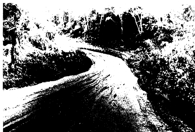
27. texture argileuse après un orage, un véhicule deux ponts est nécessaire pour franchir cette zone - Gabon région de Bitam
