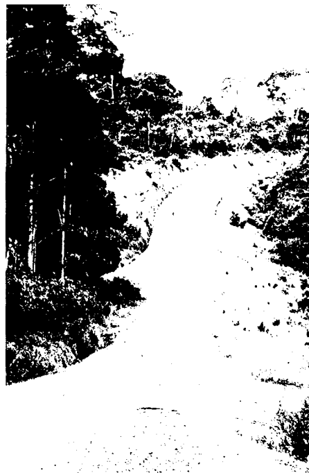
route élaborée au Gabon .6 (forêt des abeilles) chaussée en graveleux latéritique
