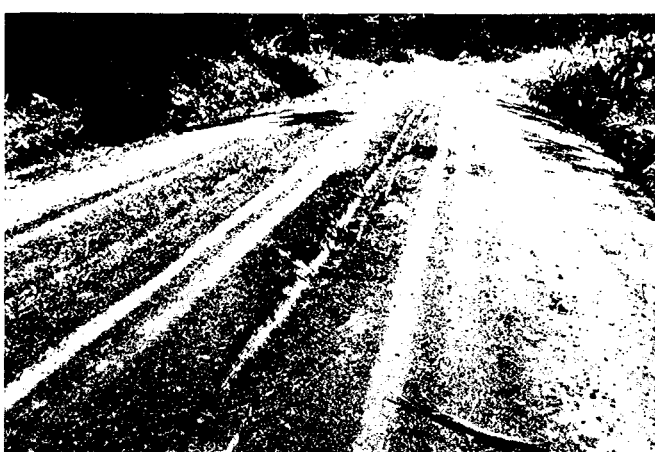
28. texture argileuse; frayée centrale qui n'a pas pu être réparée durablement par le reprofilage léger
