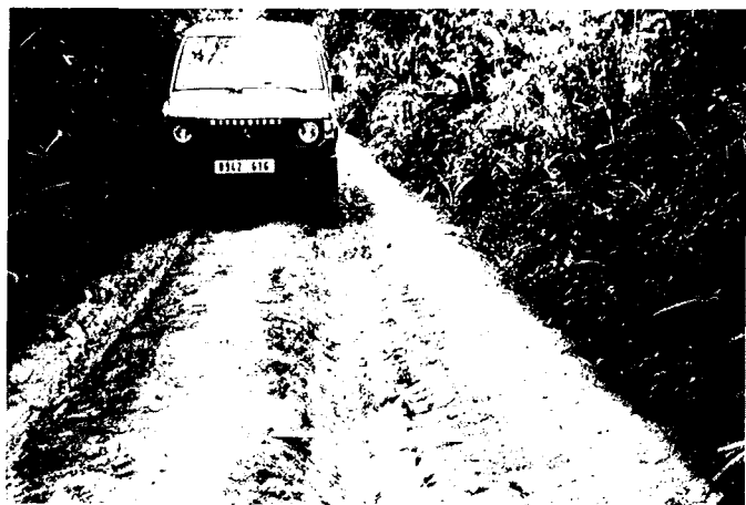
51. ornièrage dû à l'action combinée du trafic (canalisé sur 1 voie) et de l'eau (décohésion du sable)
