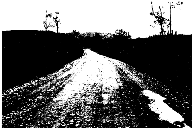
35. texture pierreuse, galets roulants ou enchassés dans une matrice argileuse Colombie
