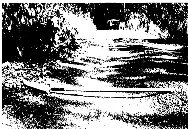
44. ornièrage dû au rejet des gravillons sur les côtés et au centre (Gabon)
