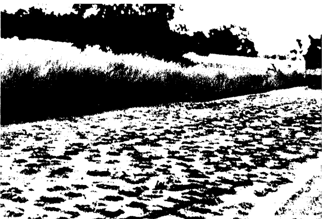
33. texture pierreuse; blocs de cuirasse latéritique belle planche d'essai pour amortisseur - l'ancienne route Sikasso-Koutiala (Mali)
