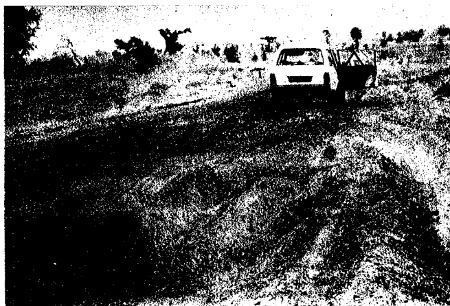
147. base instable et sans cohésion "le revêtement ne fait pas la route à lui seul !"
