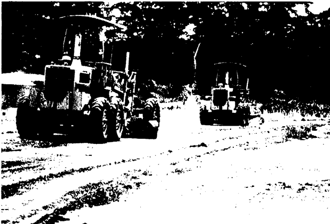
83. profilage avec deux niveleuses en tandem, sans apport de matériau ni de compactage
