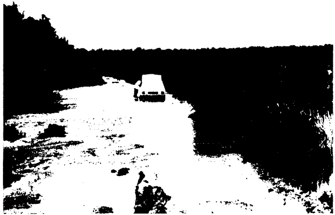
60. ce qui arrive quand la route est creusée au-dessous du TN - ancienne route Sikasso-Koutiala (Mali)
