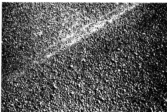
19. ségrégation sous trafic - les bandes de roulement sont dépourvues de graveleux libres chassés sur les bords
