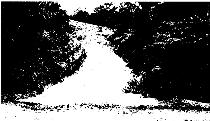
63. exutoire latéral destiné à évacuer l'eau des fossés - réalisé à l'envers il alimente la chaussée
