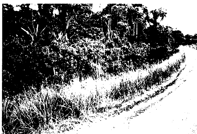
20. graveleux roulant dans un virage dû au rejet provoqué par le nivellement du petit entretien
