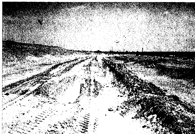
30. texture sableuse; dessiccation et perte de cohésion en surface - Sahara Tunisien - route Nefta-Azoua
