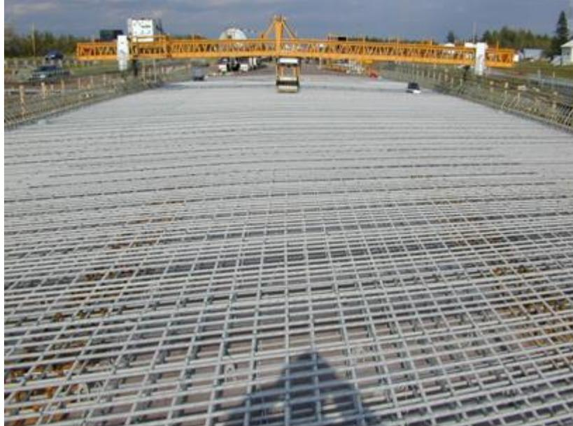
Armatures internes en matériaux composites pour un tablier de pont
