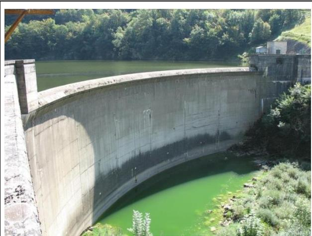
**Figure 2.** *Barrage de Choranche. Appuis au rocher en rives (2013).*
