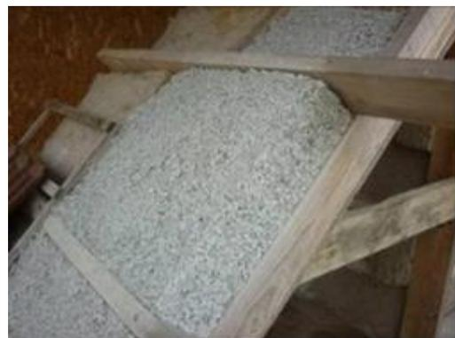
*Utilisation du béton de chanvre pour l'isolation des toitures*
