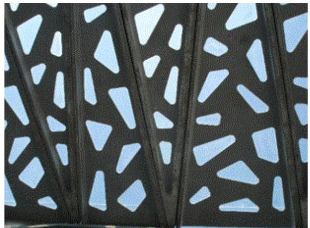
*Principe de l'étanchéité par emboîtement d'éléments préfabriqués en BFUP appliqué pour la couverture du stade Jean Bouin (au-dessus : éléments séparés avant mise en place ; en-dessous : assemblage installé) et destiné à être repris dans l'application étudiée*
